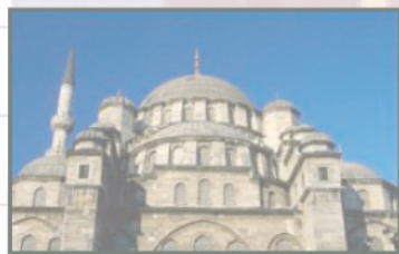
Exterior de Yeni Cami
